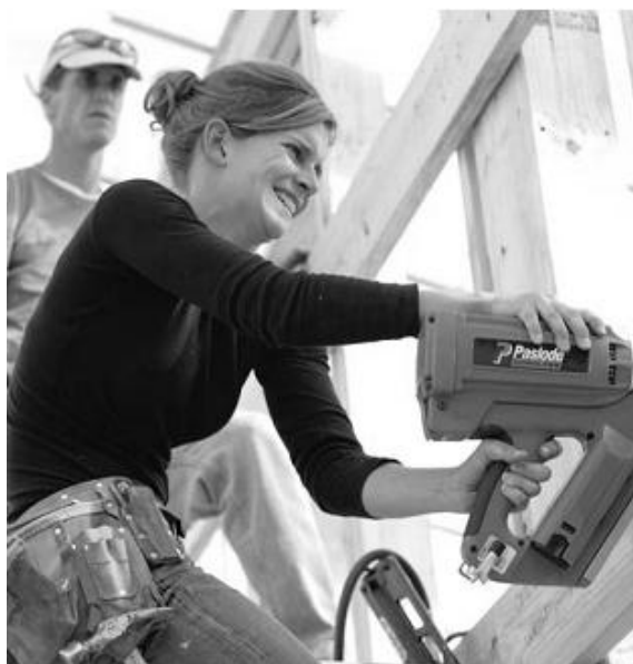
多くの個人ボランティアや団体が、1日の「突貫工事」で懸命に家の骨組みを組み立てている
